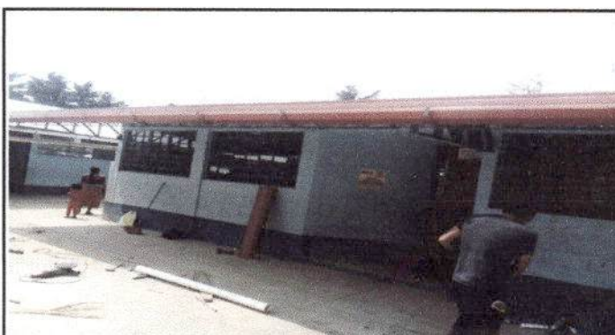
Foto 4: instalacion de canales y bajada de agua
