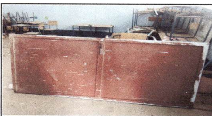
Foto 6: Cambio de puertas
