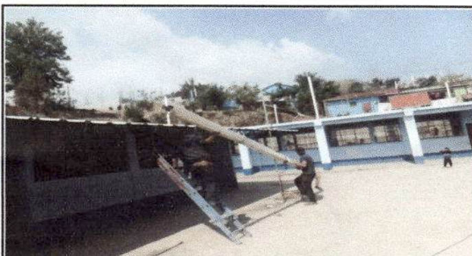
Foto 3: Desmontaje de canales y bajada de agua pluvial
