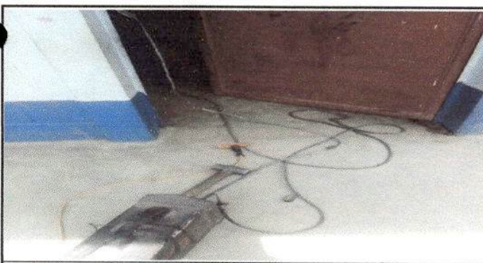
Foto 5: Reparacion de puertas
